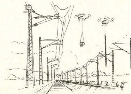
Hubschraubereinsatz bei der Streckenelektrifizierung
