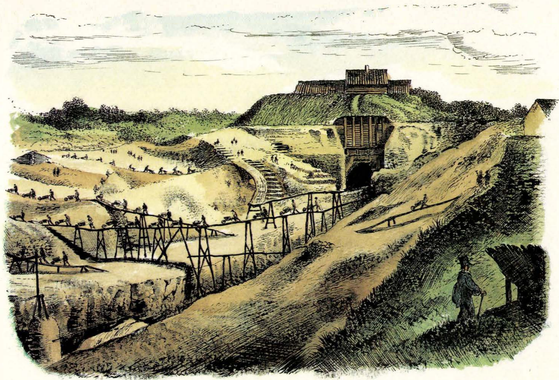
Tunnel bei Oberau im Bau
