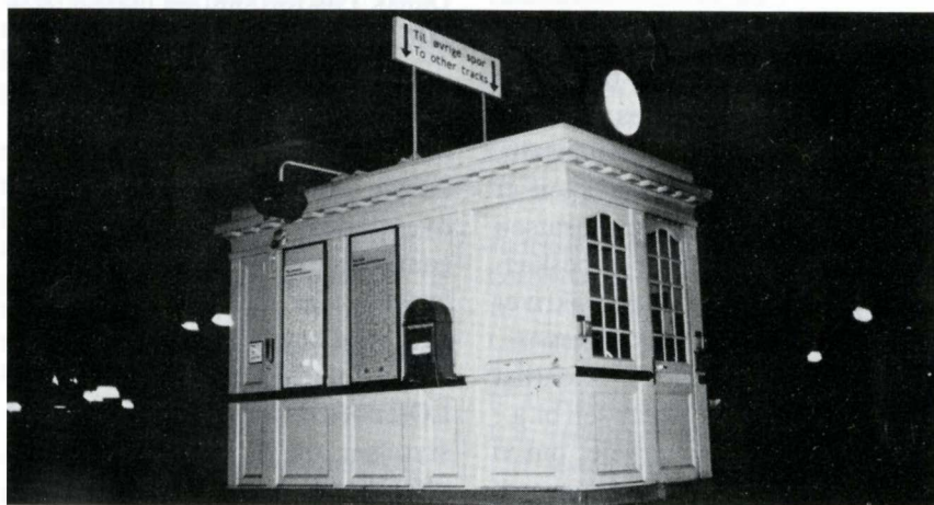
Opholdsbygningen på Kh.
