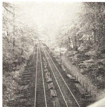
Helt til højre i billedet banens indføring til Vedbæk station
