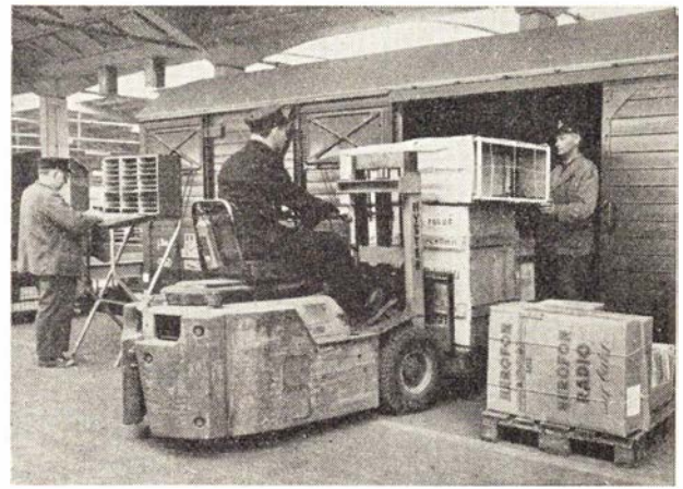
Fig. 2. Tømning af stykgodsvogn ved hjælp af gaffeltruck
