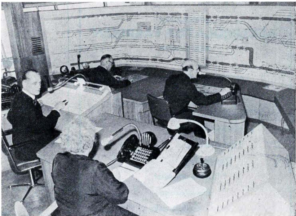
I forgrunden højtalerbetjening (12), banegårdens opslgshavende (13) og strækningmeldetavlen (9 og 10)
