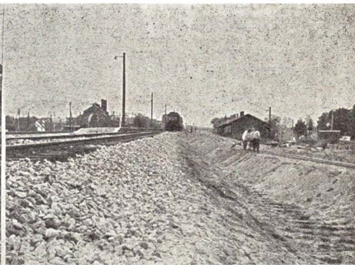
fig. 6. Stationspladsen i Vamdrup løftes ca. 2,5 m.
