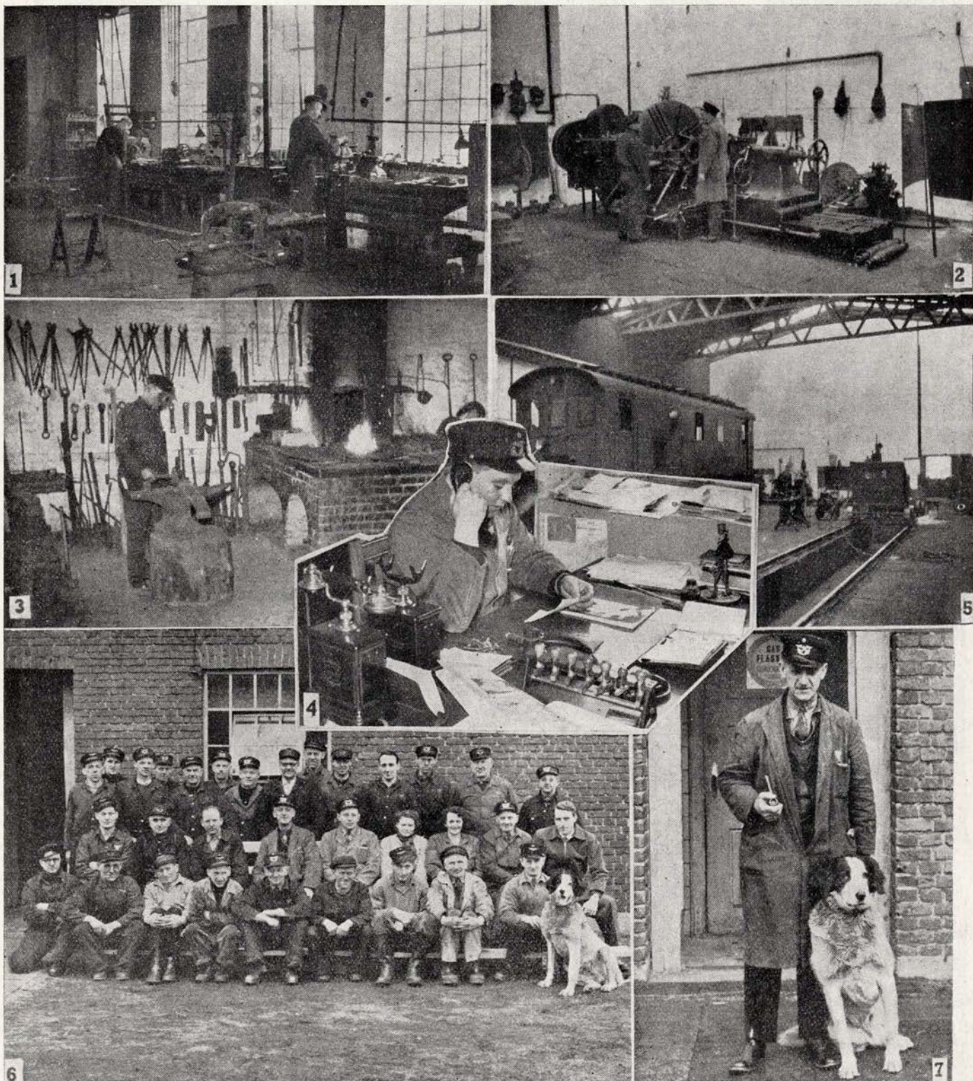
1) drejerværksted 2) hjulafretningsværksted 3) smedeværksted 4) værkfører B. Nissen 5) vognværksted 6) værkstedspersonalet 7) værkstedsformand H. Pedersen og Bamse
