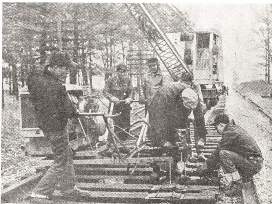
Den nyeste sporlæggermaskine betjent af 3 mænd lægger sporvidde, borer huller i svelleterne og slår anchorspiger i. Maskinen sparer 60 mand pr. dag.
