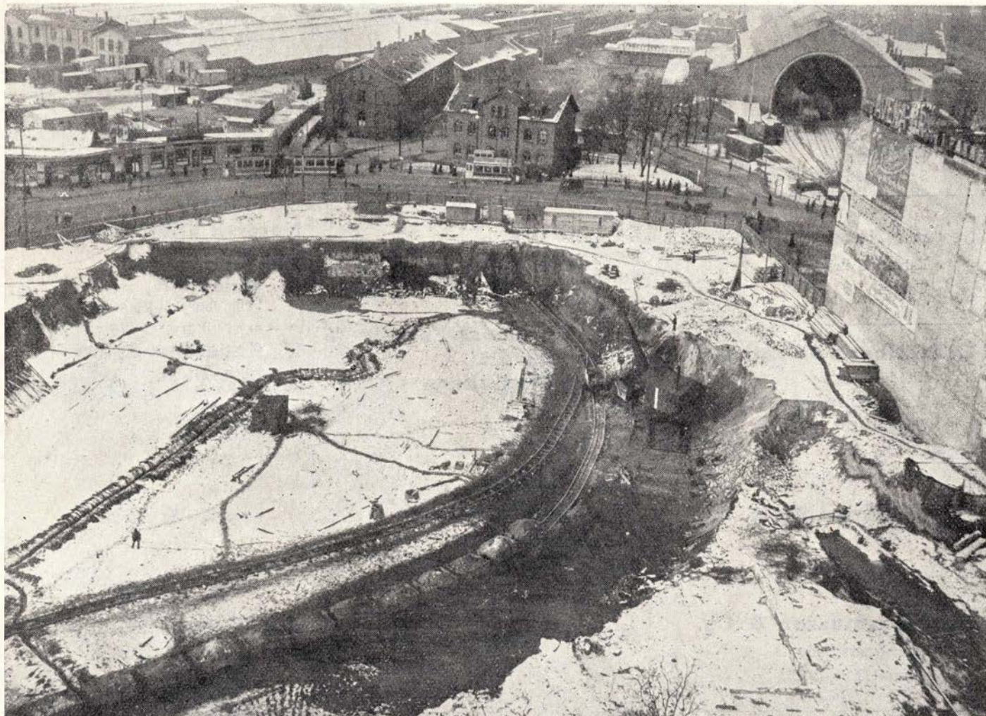
Udgravningen til den nye hovedbanegård. — Til højre Panoptikonbygningen, længere tilbage den gamle hovedbanegård. I baggrunden t. v. den gamle godsbanegård.
