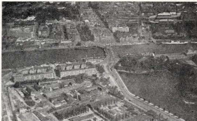
Om også dette tager sig småt ud, er det let nok at kende Langebro og fregatten „Jylland“.
