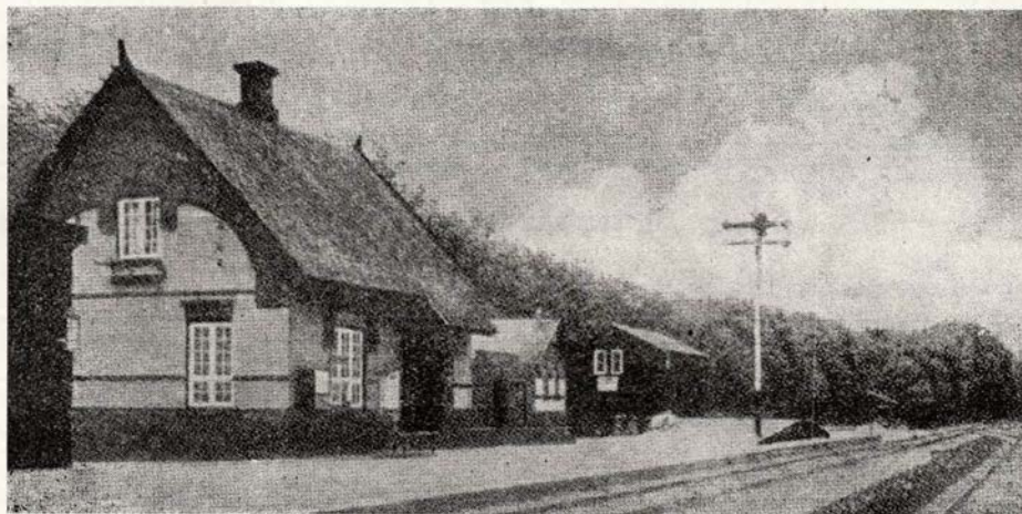
Hareskov med det særprægede Signal. Vingerne er fast forbundne. Den ene Vinge er hvid, den anden sort af Hensyn til Synligheden mod Skoven.
