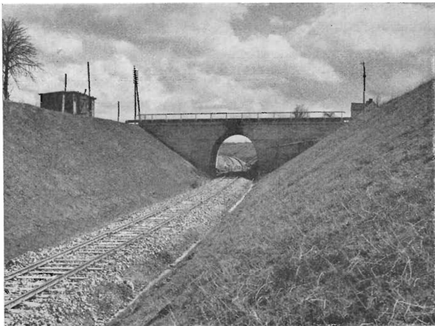
Viadukten ved Gørløse
