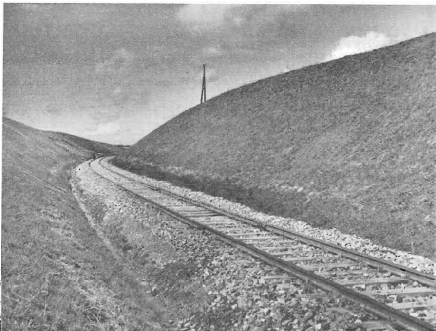
Udgravningen ved Gørløse
