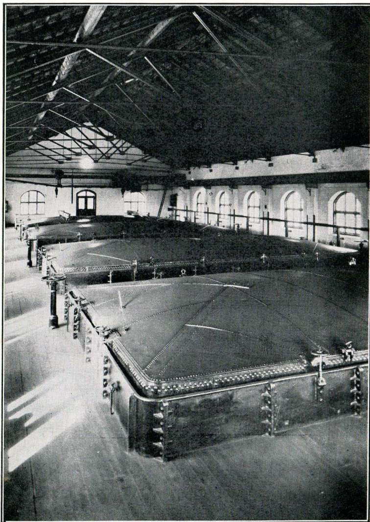
RENSEANLÆG FOR GAS - KAPACITET 35000 M 3 PR. DØGN
