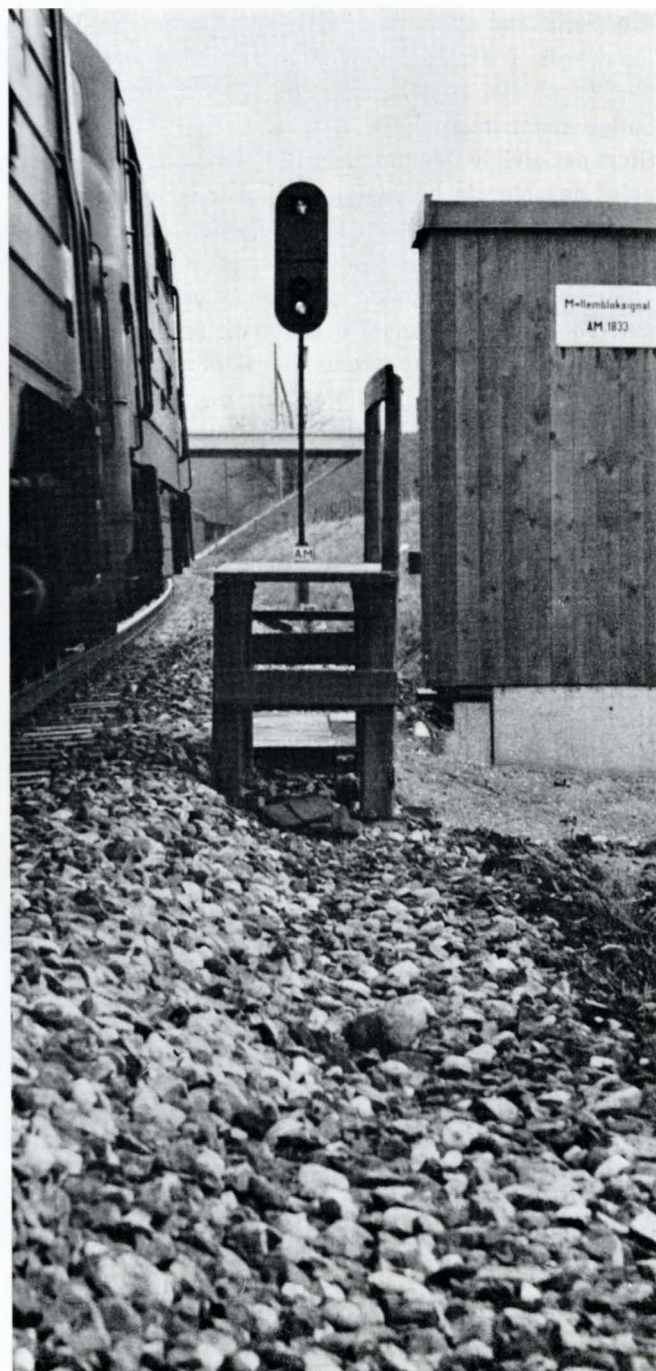
Stadig flere manuelt betjente blokposter nedlægges og erstattes af automatiske bloksignaler, herved opnås en ikke ubetydelig besparelse af personale.
