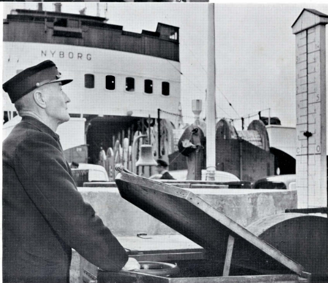
Broklappen sænkes som forbindelsesled mellem færgen og land.
