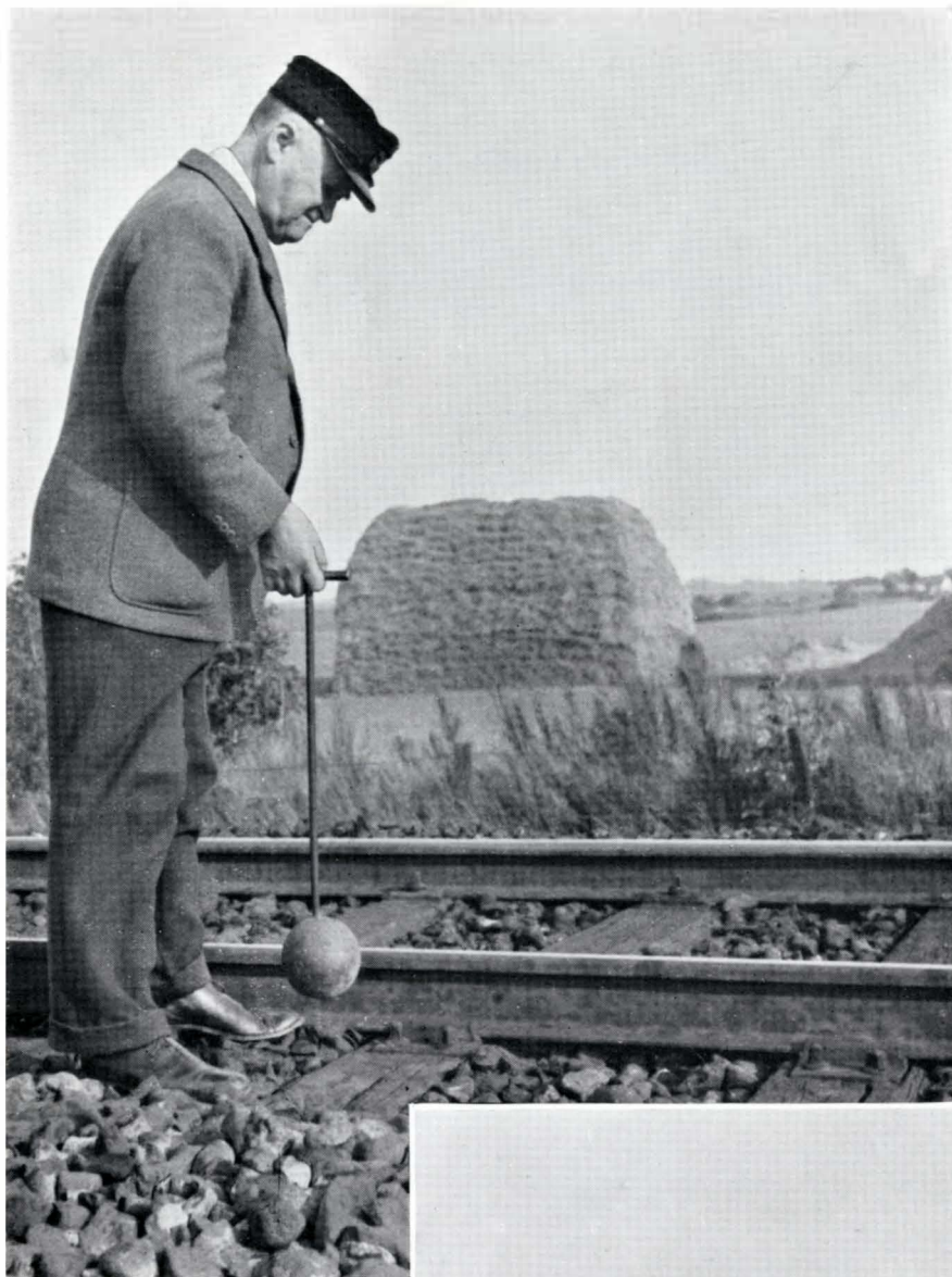
Overbanemesteren undersøger med en »kuglebanker«, om svelleterne er fast understøttet.
