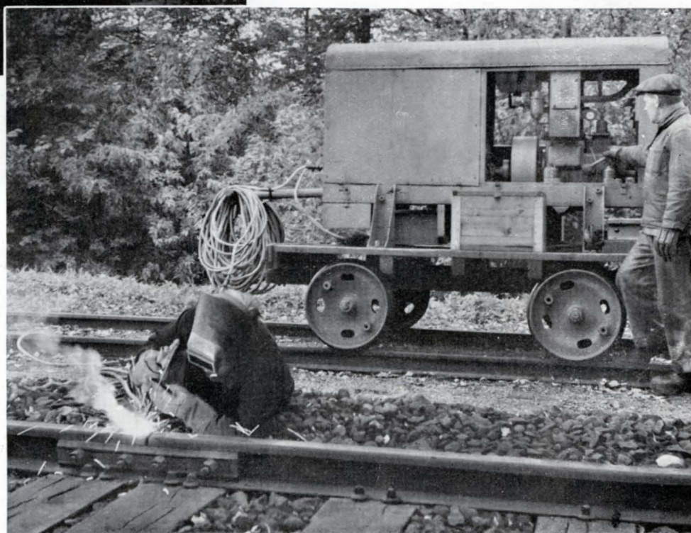
En »skinneforbinder« påsvejses et skinnestød på en elektrificeret strækning.
