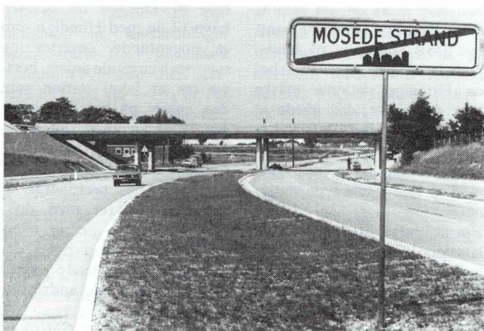
S-banens krydsning med Mosedø Landevej.
