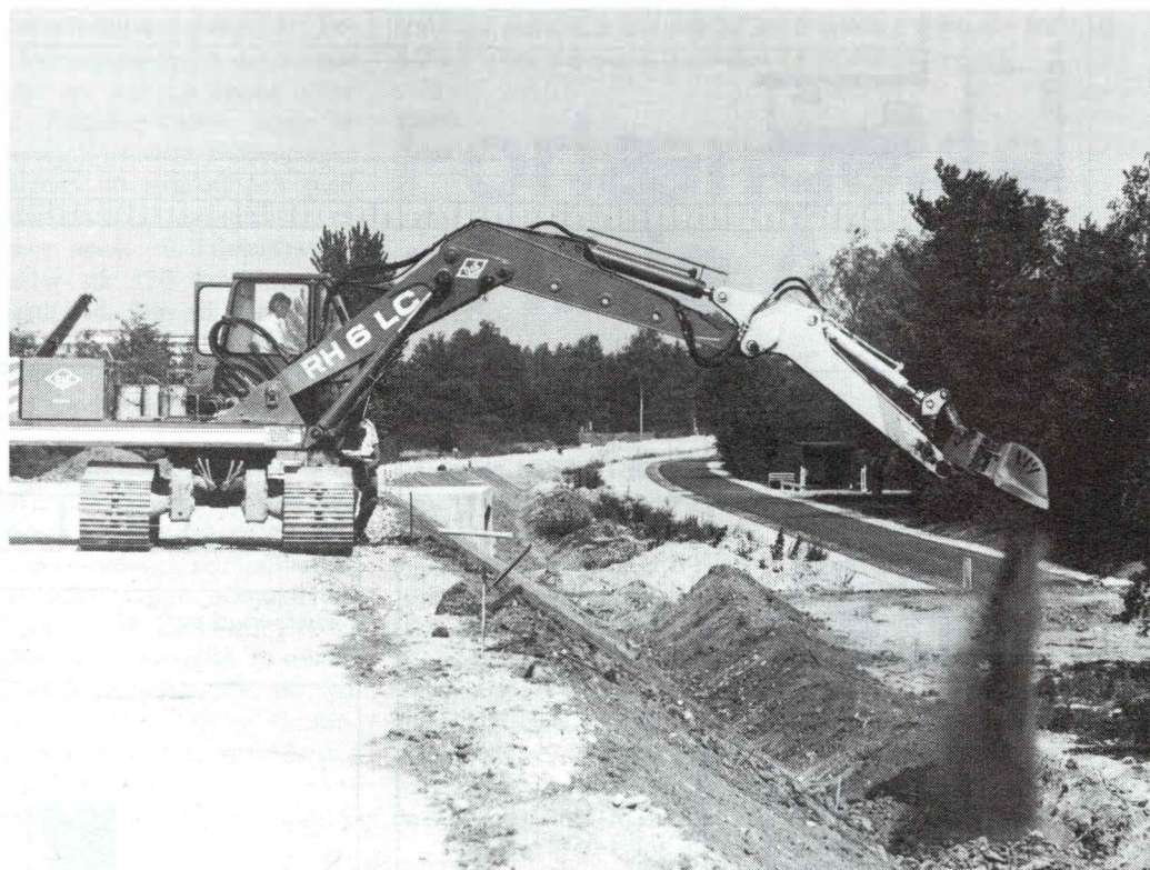
Jordarbejder nord for Mosedø Landevej.
