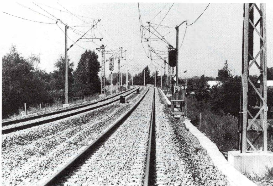
Banestrækningen umiddelbart syd for Vallensbæk.
