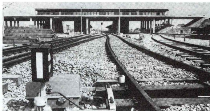
Hundige stations placering på et broanlæg fremgår klart af dette billede taget fra sydenden af stationsområdet.
