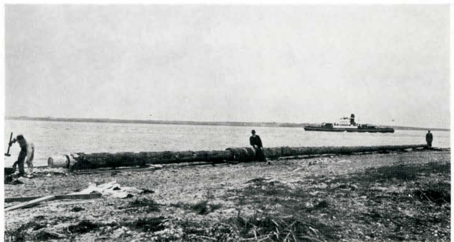
En sammensat Pæl. Topenden er til-dannet af Hensyn til Paasætteren
