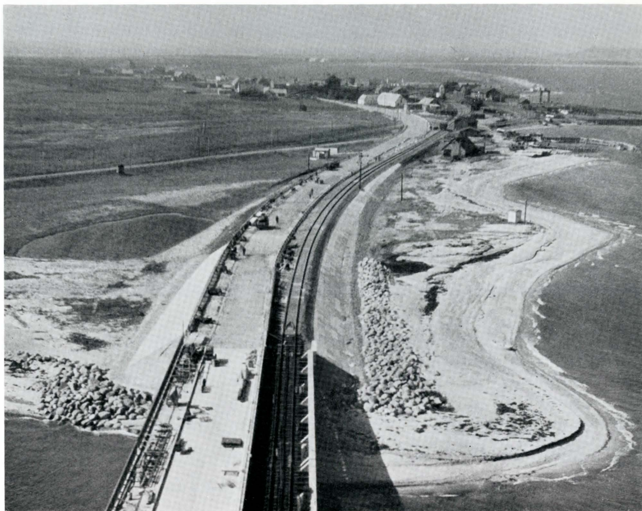
Dæmningen i Oddesund Nord. Paa de mest udsatte Strækninger er Skraaningerne beskyttet med Glacis og Stenkastning. I Baggrunden Oddesund Nord Station med det gamle Færgeleje. Sammenlign iøvrigt med Billedet af Oversvømmelsen paa Side 28
