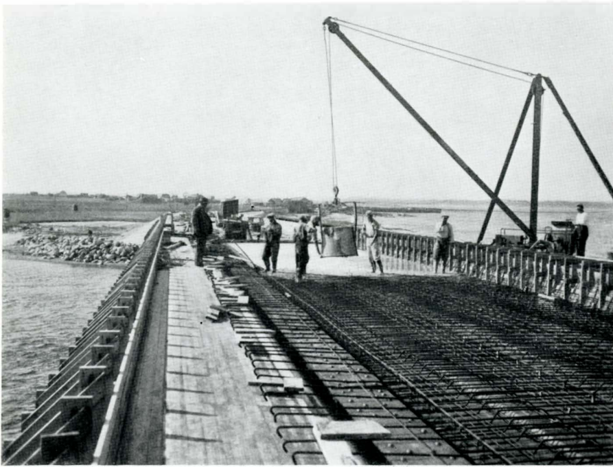
Bæredækket støbes. Betonen blandes i et flydende Blandeanlæg og hejses op med Kran
