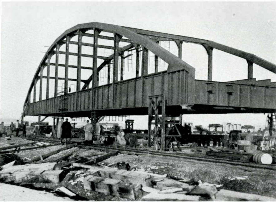
Et færdigsamlet Brofag løftes ved Hjælp af 4 Loftetaarne
