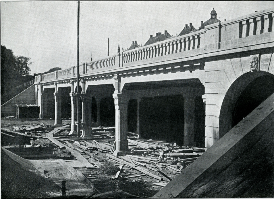
Viadukt for Østerbrogade
