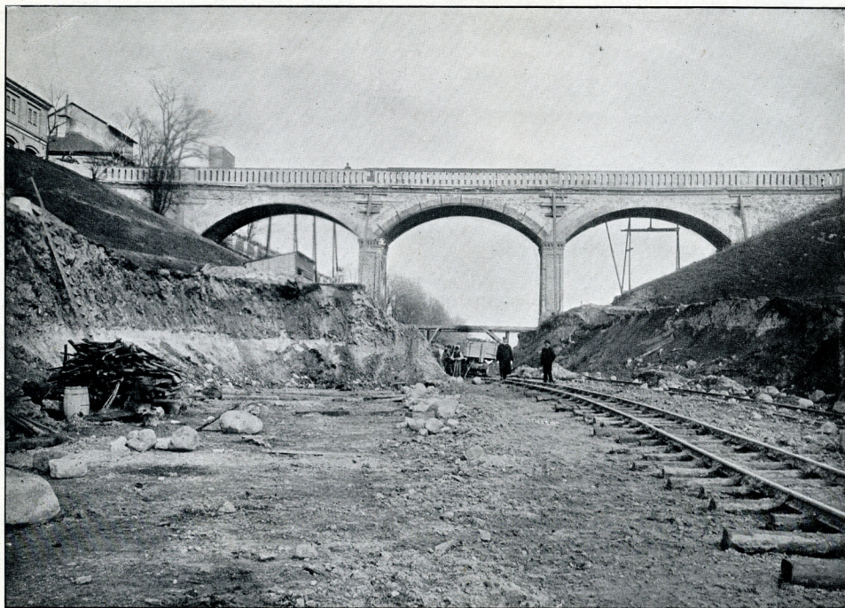
Den gamle Viadukt ved Carlsberg
