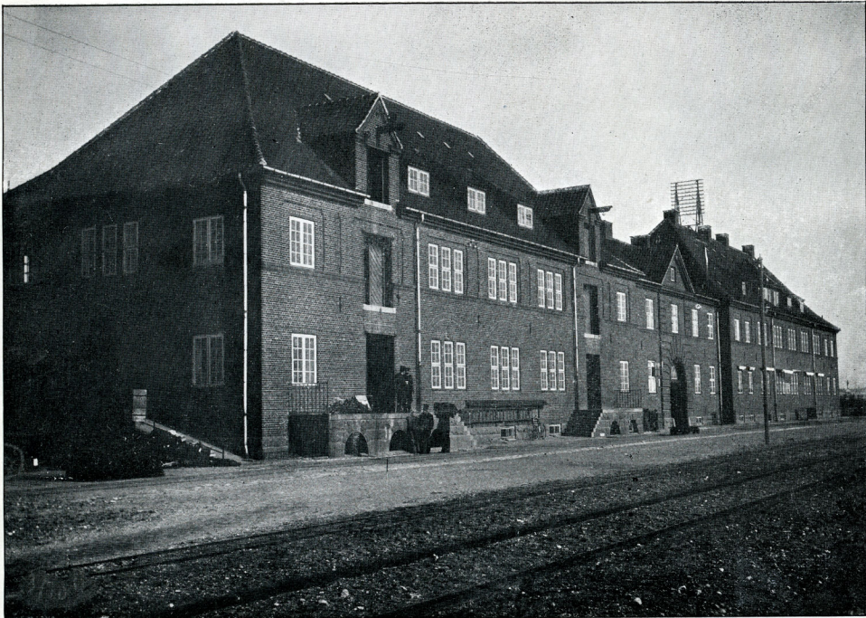
Kontor og Magasinbygning
