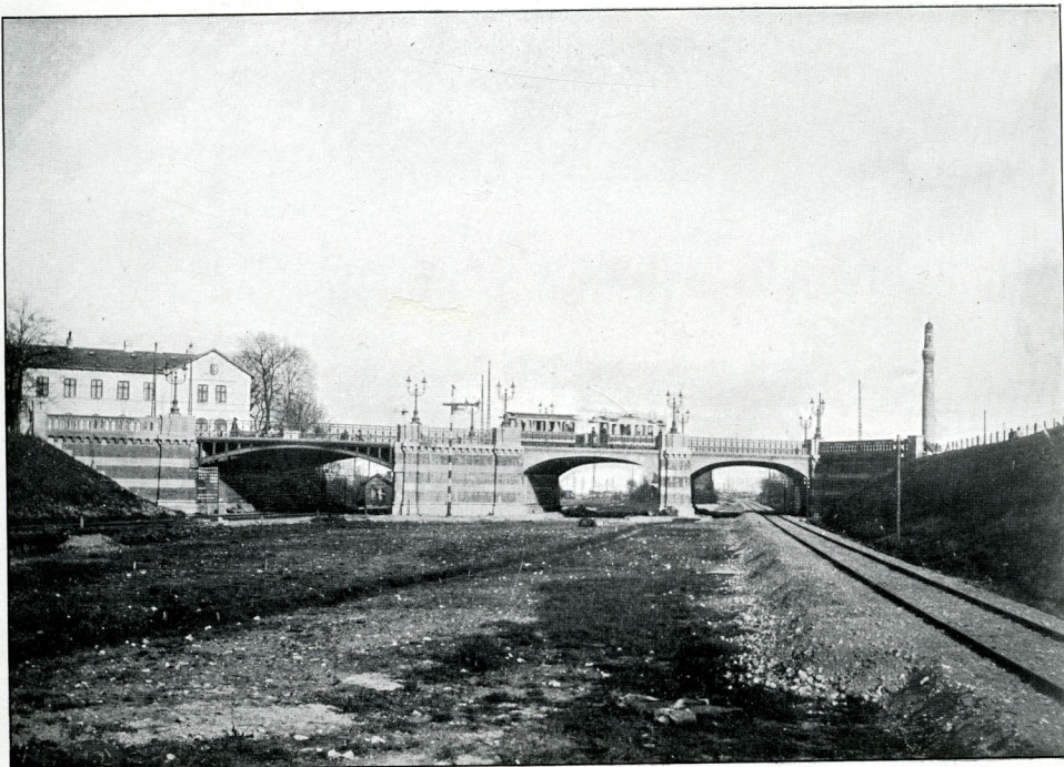
Viadukt for Strandvejen ved Svanemøllen
