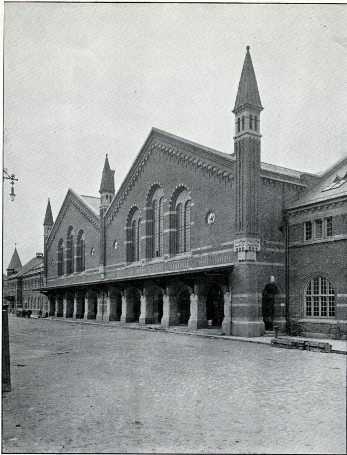
Hovedbygning, Facade mod Bernstorffsgade
