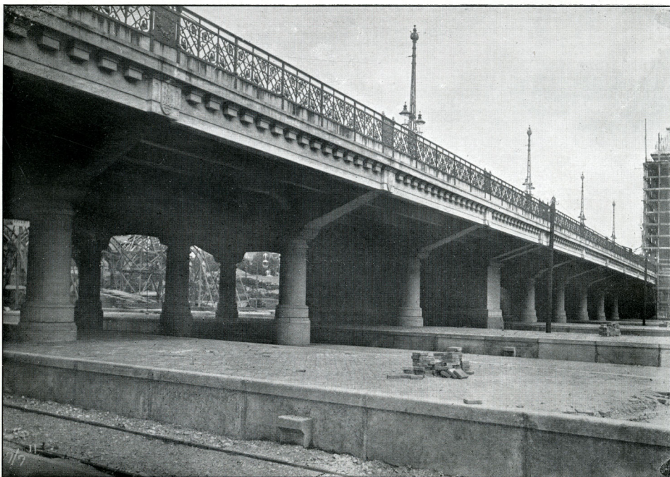
Viadukt for Tietgensgade
