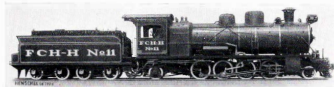
Bild 258. Heißdampf-Zwilling-Güterzug-Lokomotive für Peru Hauptabmessungen: Nr. 23, Seite 172 914 mm Spur, Ölfeuerung
