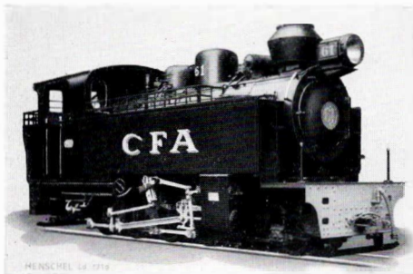
Bild 224. Naßdampf-Zwilling-Tenderlokomotive der Amboim-Bahn (Portugiesisch-Westafrika)
