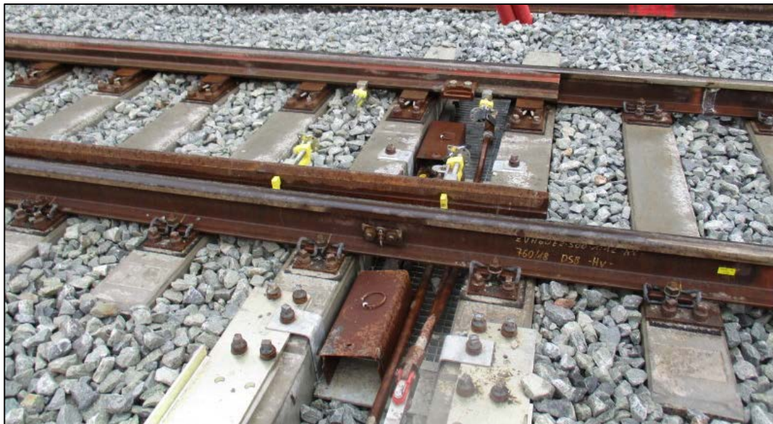
Billedet viser placering af låsebolte.
