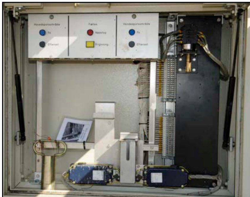
Skab med nødpanel type DSB 1990
