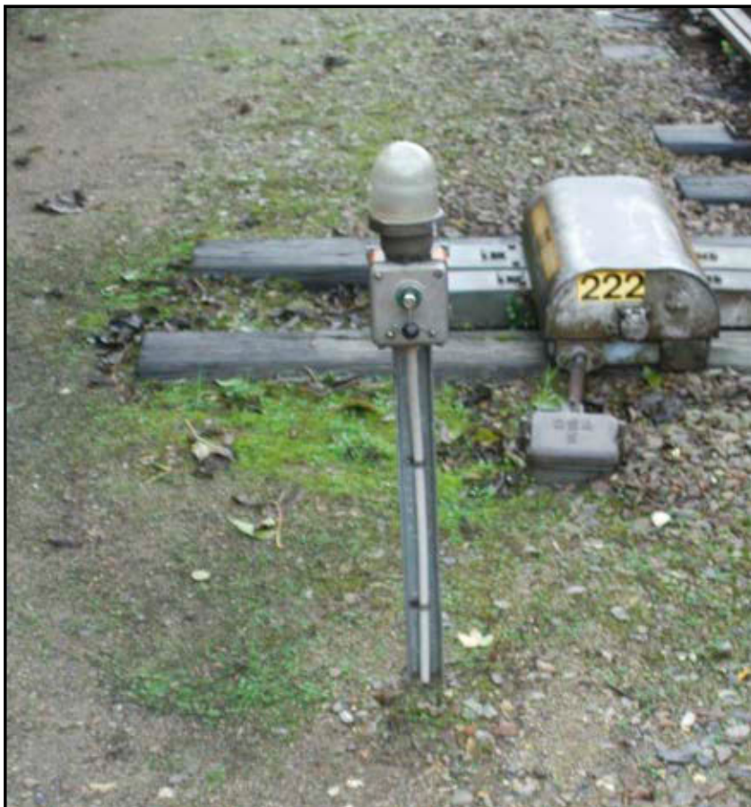
Centralaflåst sporskifte med el-stedbetjening
