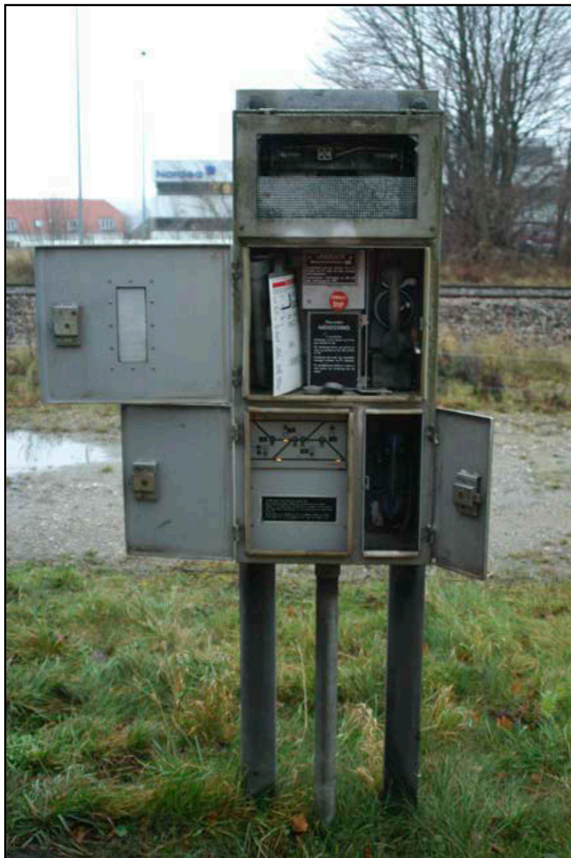
Betjeningskab type DSB 1953, 1953/54, 1954, 1972, åbent
