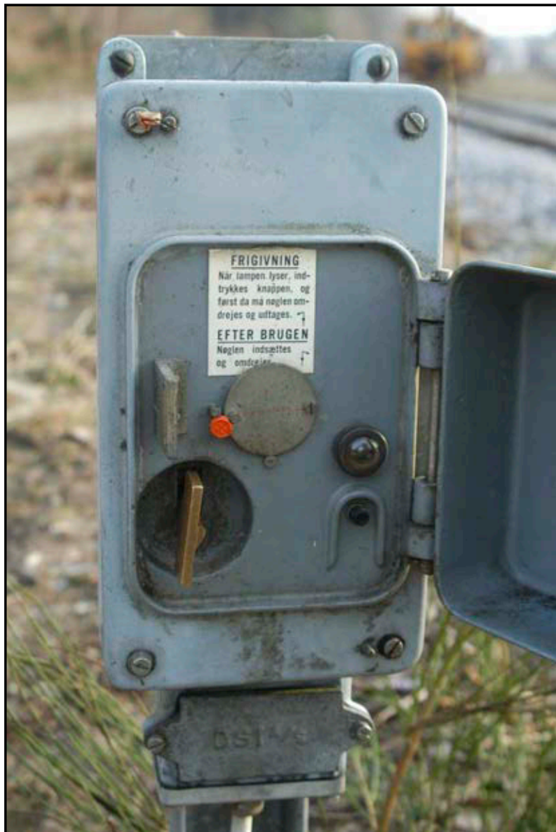
Skab med hovednøgle til elektromagnetisk nøgleaflåst sporskifte
