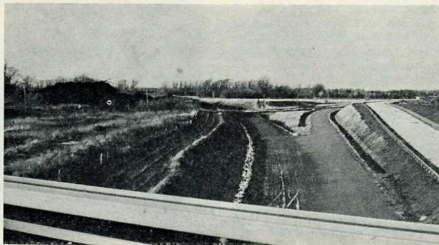
Fælledvejsviadukten. Tv. spor til Hjørring. Planum for Skagensbanen th.
